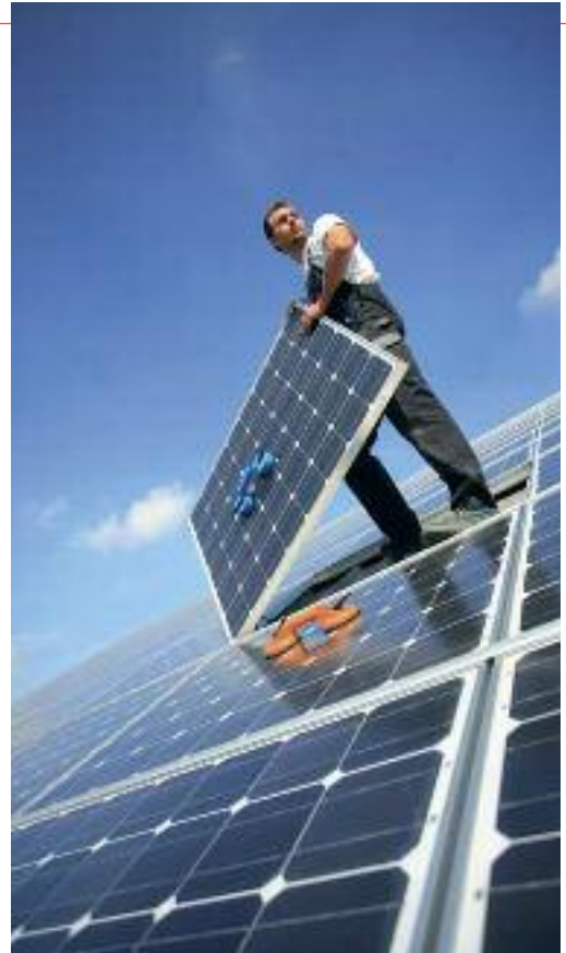
Die Solarstromtechnik macht es möglich - wenn Tages- bzw. Sonnenlicht auf eine Solarzelle trifft, wird eine Spannung erzeugt, die an der Oberfläche abgenommen werden kann. Durch den photovoltaischen Effekt können wir Licht in Strom umwandeln. Diese Umwandlung geschieht ohne Belastung der Umwelt, nämlich lautlos, geruchs- und emissionsfrei.
